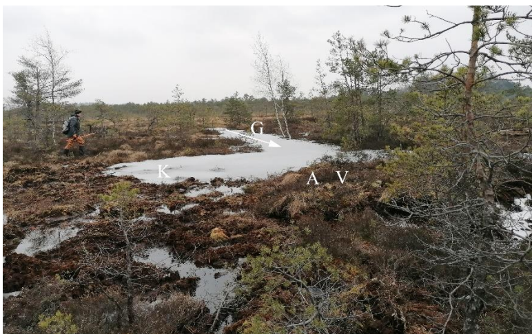
6.13. attēls. Kūdras aizsprosta izbūve 2020. gada rudenī (augstāk) un apsekošana pēc pieciem mēnešiem 2021. gada pavasarī (zemāk) Madiešēnu purvā DL "Augstroze". Grāvī (G) cēlies ūdens līmenis; Kūdras ieguves vieta (K) ir aizpildījies ar ūdeni un vizuāli purva ainavā atgādina lāmu; Aizsprosta (A) virsma ir nedaudz nosēdusies; Veģetācijas velēna (V) uz aizsprosta pavasarī vēl nav sazaļojusi. Foto: A. Priede, L. Strazdiņa
